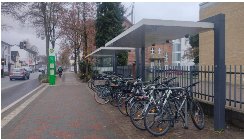
Abbildung 2-25: Fahrradabstellanlage an der Haltestelle "Gesamtschule" (Quelle: Stadt Bad Lippspringe)
